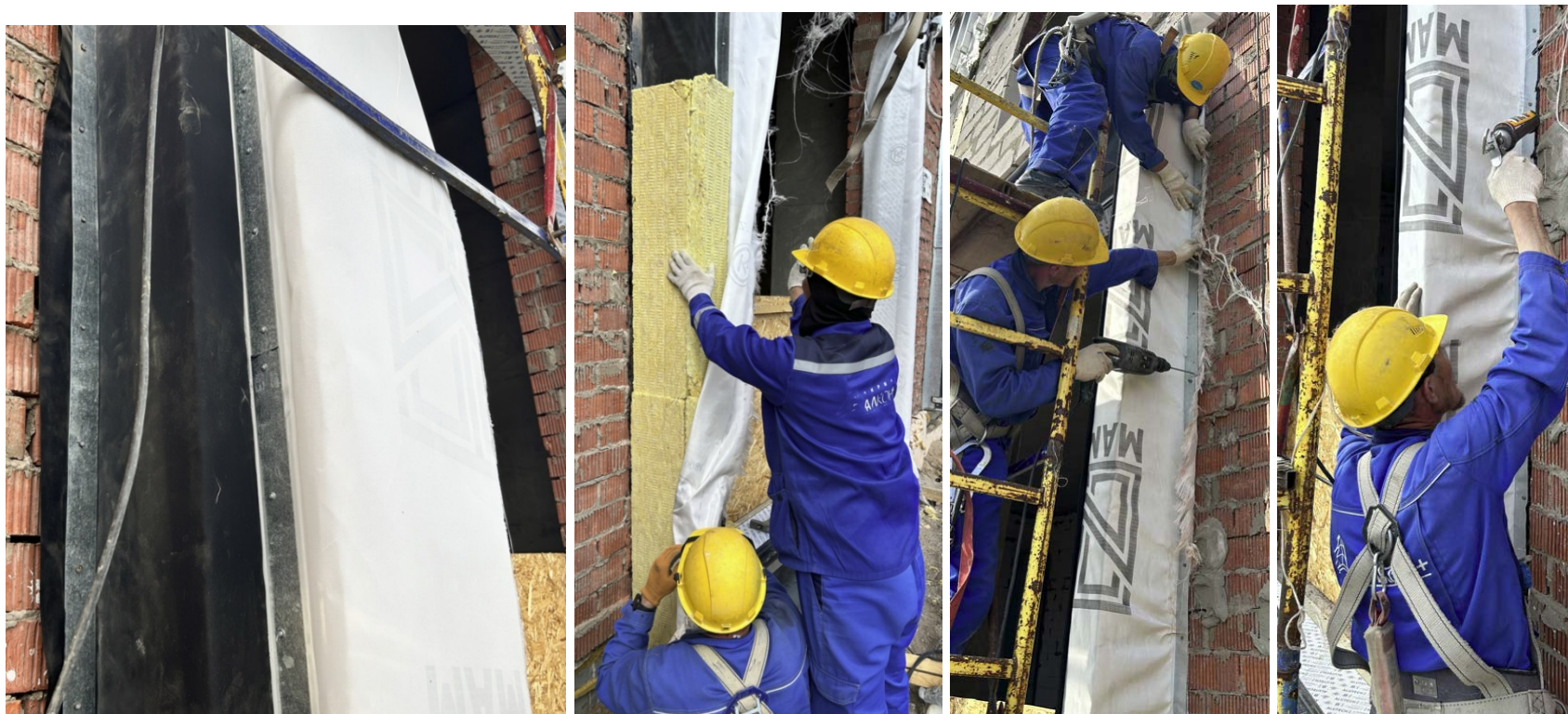
1.11-сурет – Витраж қаңқасы ойығын герметизациялау
