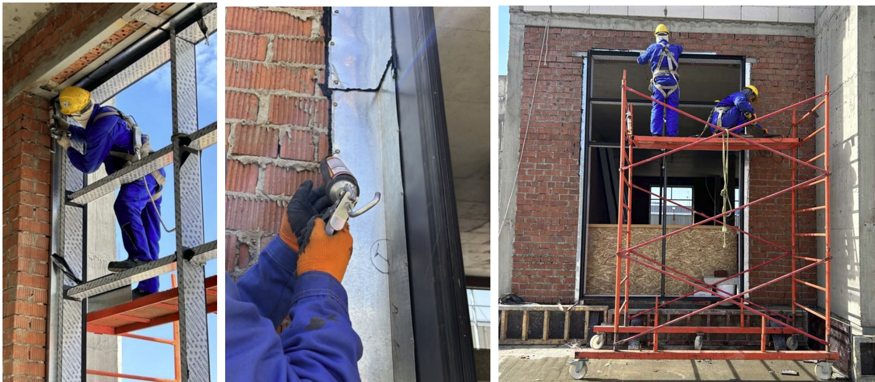
1.10-сурет – Ойық периметрі бойынша мырышталған болаттан өртке қарсы тосқауыл орнату
