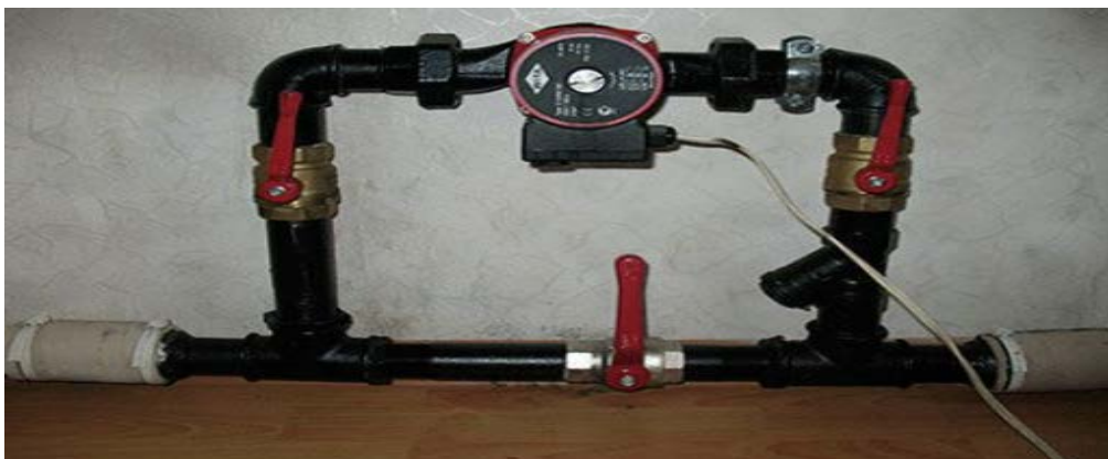
2.9-сурет – Жылыту айналма жолындағы циркуляциялық сорғының жалпы көрінісі
