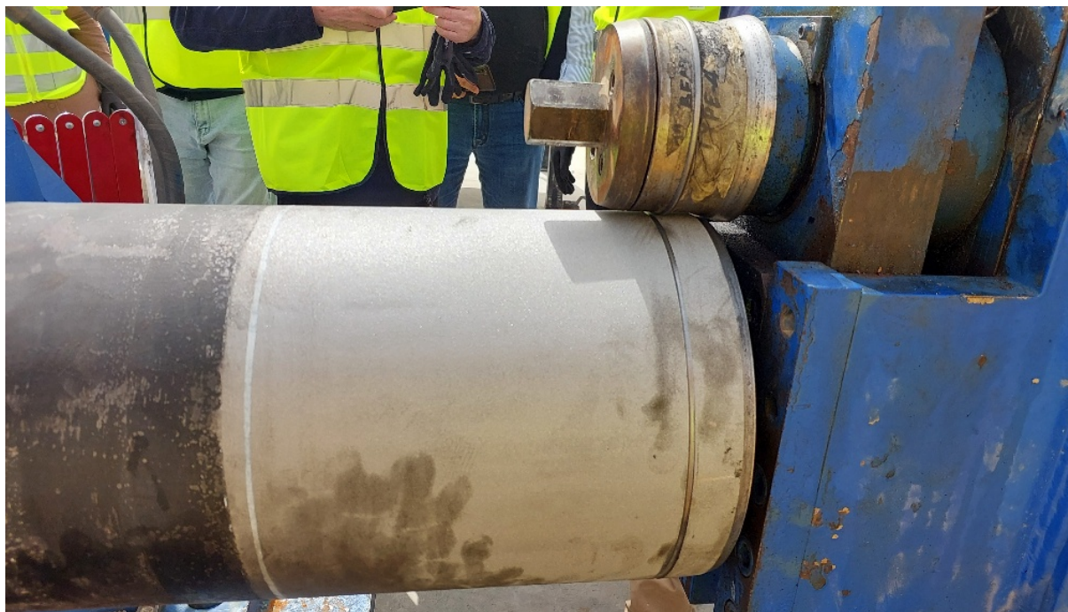
9-сурет – Құбырдың түйреуіш ұшын қалыптастыру
