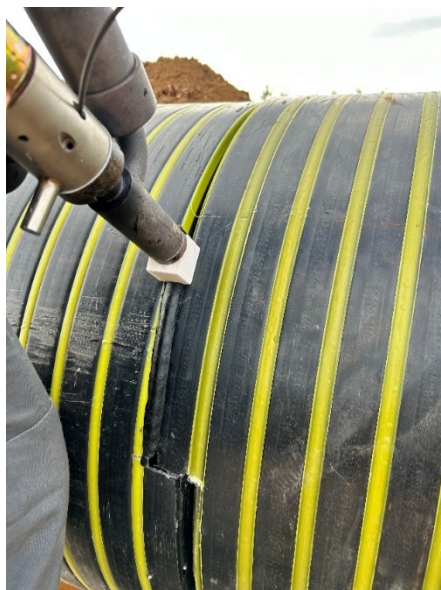
5-сурет – Құбыр түйіспелерін дәнекерлеу
