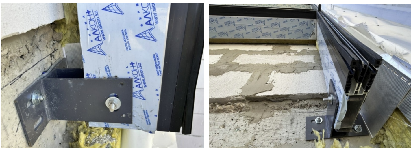
1.6-сурет – Жабын плиталары бойынша монтаждalған кронштейндер
