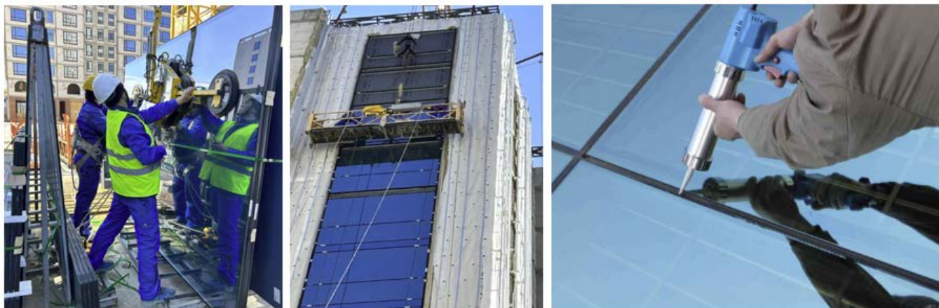
1.9-сурет – Әйнекпакеттерді монтаждау
